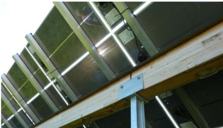
Abb. 26: Wasserablauf zwischen den Modulen durch Abstände
